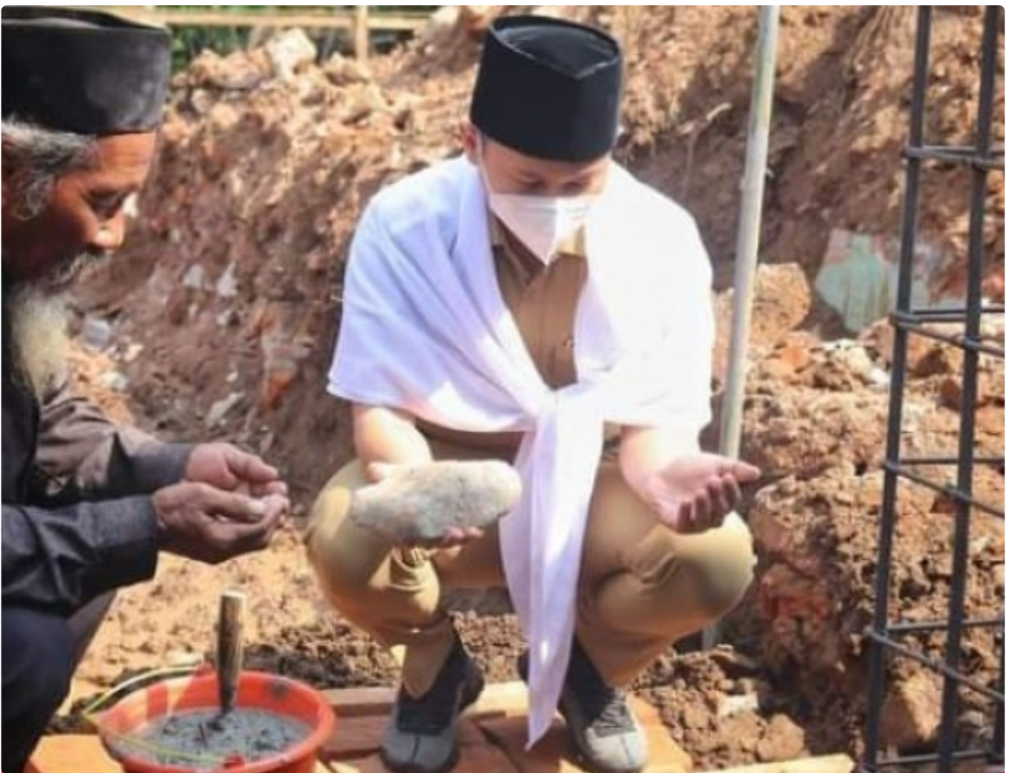
Bupati Trenggalek Mochamad Nur Arifin berdo'a sebelum melakukan peletakan batu pertama pembangunan Masjid Jama'atul Burdah di Desa Prambon, Kecamatan Tugu
